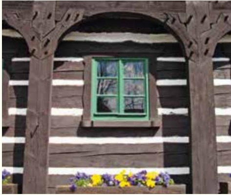
← Ständerkonstruktion des Umgebendes - Ständer, Spannriegel und Knagge sind durch Holznägeln verbunden
